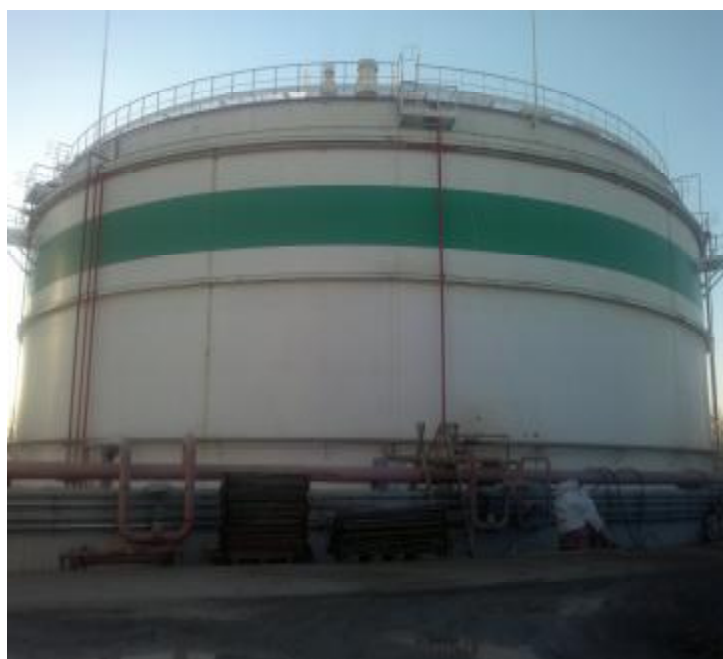
Рисунок 1 – Резервуар вертикальный стальной цилиндрический РВС-15000.
