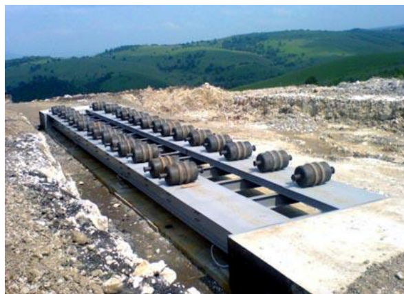
Рисунок 1 — Общий вид ГПУ весов
