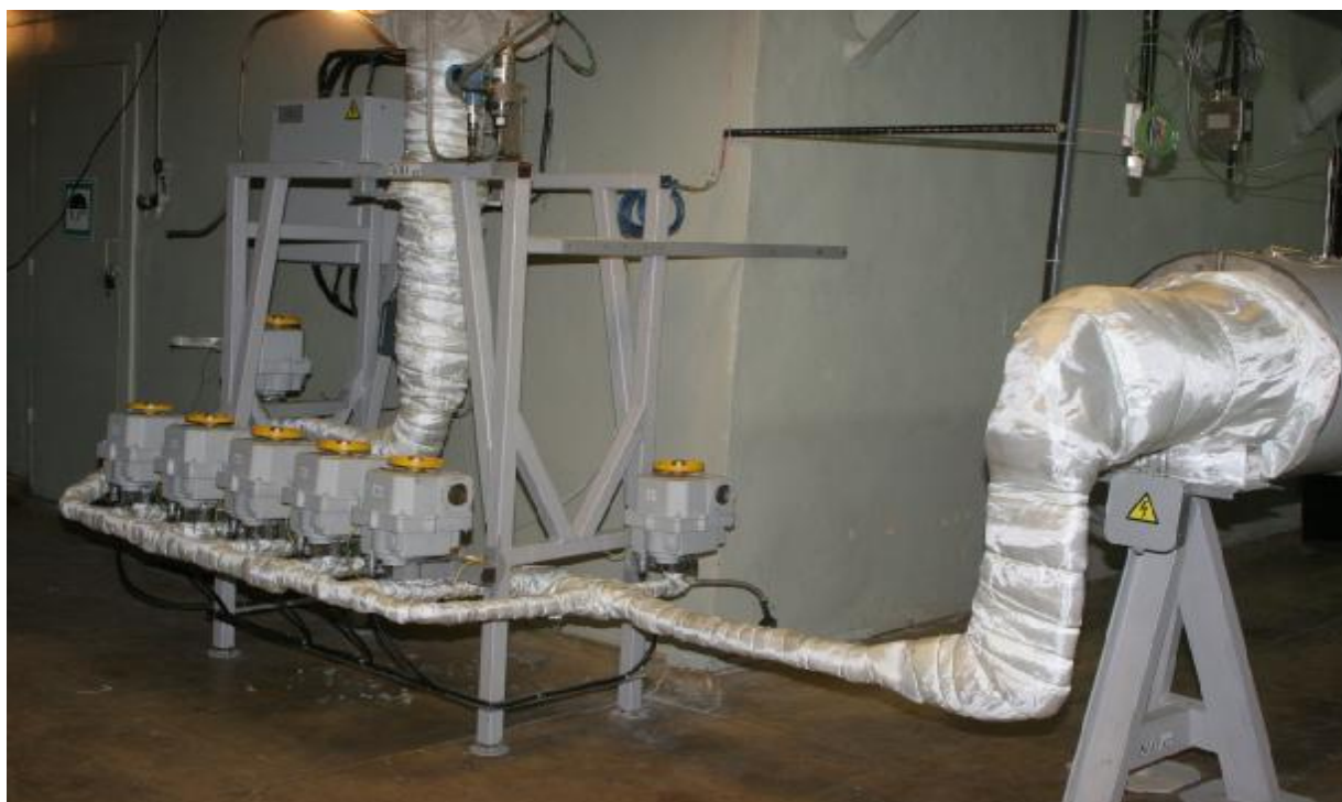
Рисунок 1 - емкость с теплоносителем, коллектор с электроуправляемыми клапанами
