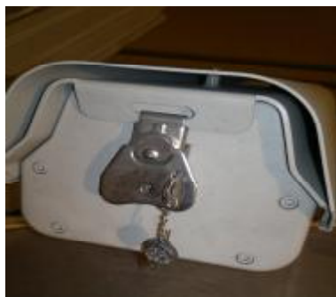
Рис. 2. Пломбирование блоков управления
