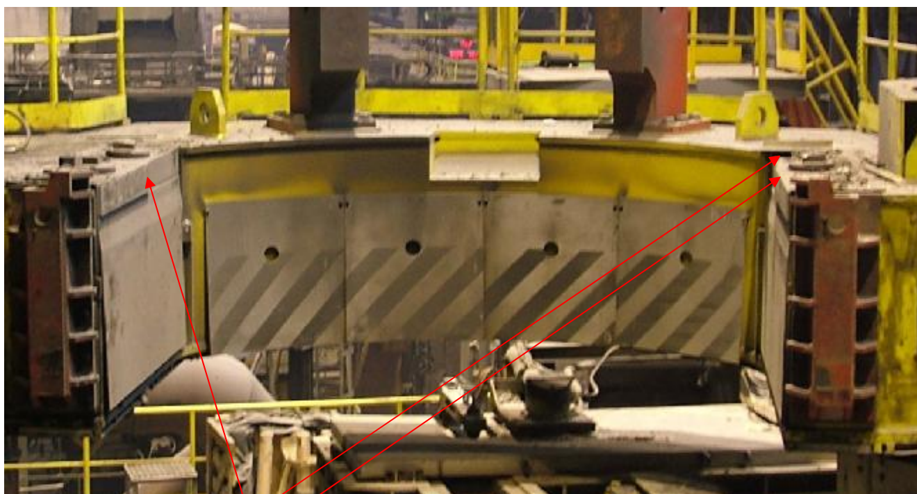
Места установки весоизмерительных тензорезисторных датчиков
