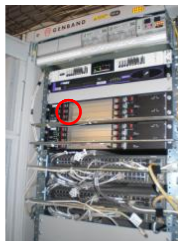
Рисунок 2 Место блокировки кассетного модуля (выделено)
