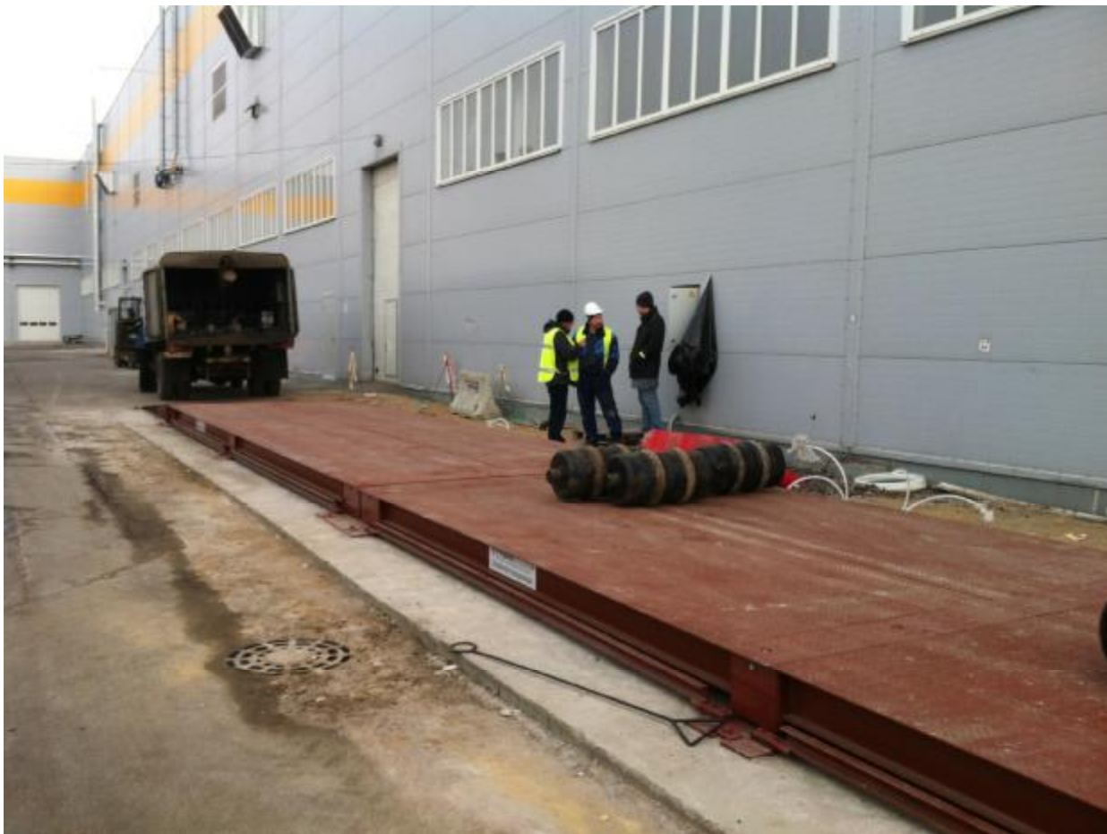
Рисунок 3 Внешний вид весов автомобильных Pfister Mobile SBP/M 18x3/60, зав. № Т 114616861, установленных в ООО «МАН Трак энд Бас Продакшн РУС», г. Санкт-Петербург, Пушкинский район, пос. Шушары
