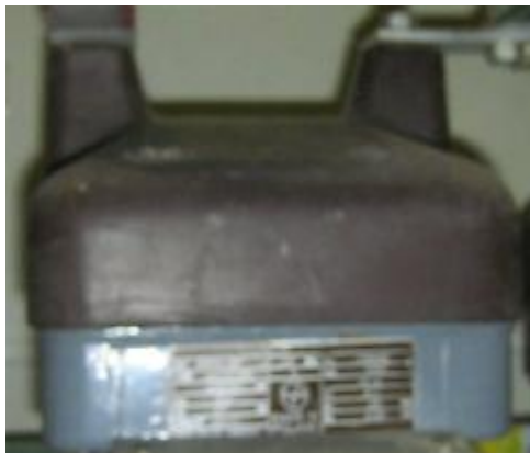
Рисунок 1 – Фотография общего вида трансформаторов напряжения VSK II 10, VSR-503, ESR 17A1
