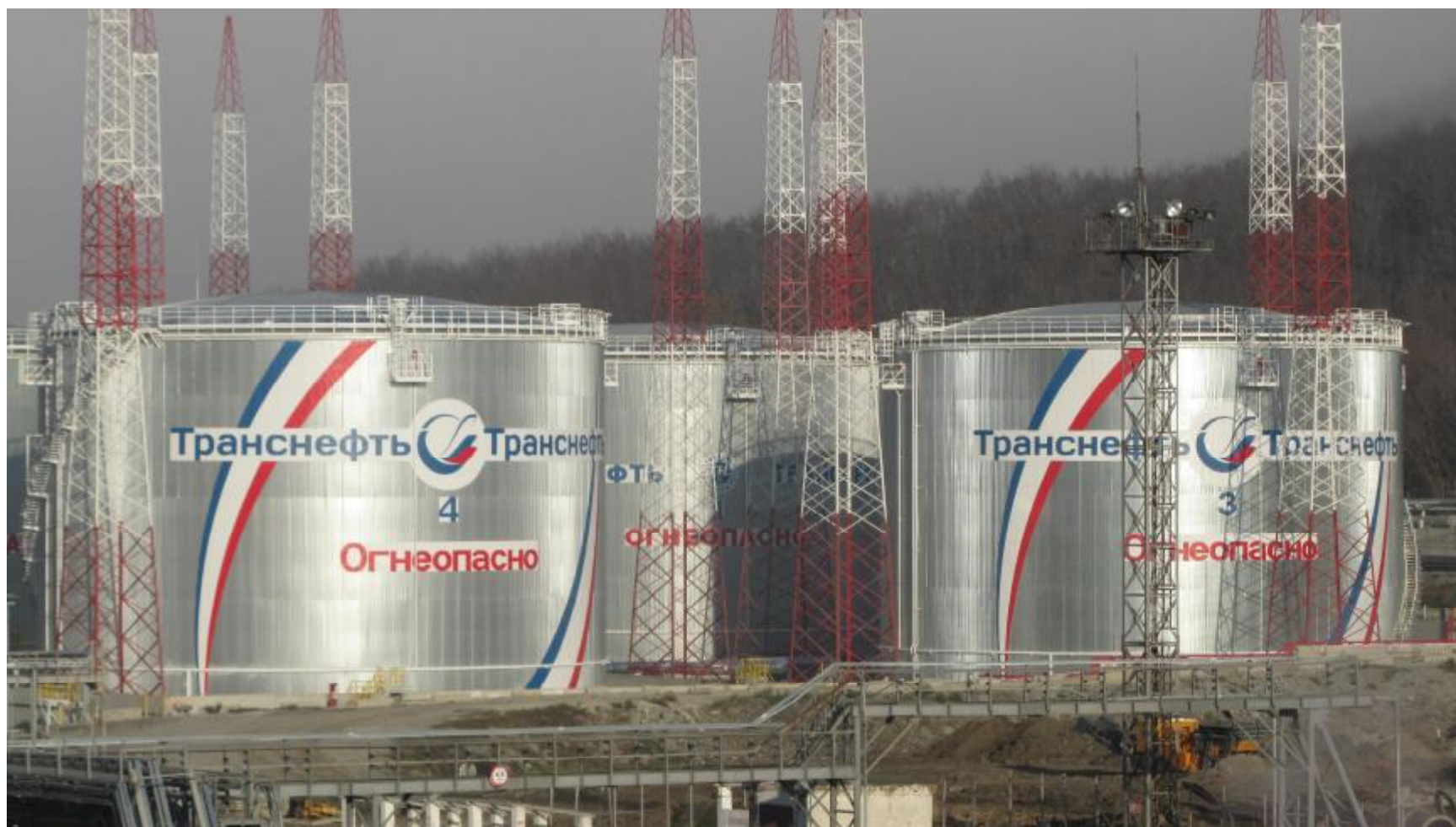
Рисунок 1. Общий вид резервуаров
