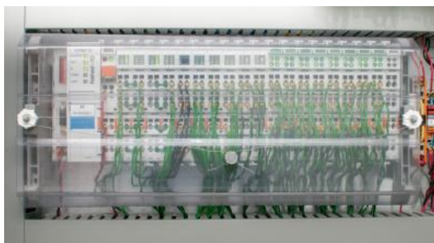
Рисунок 9 - Шкафное исполнение, место пломбирования контроллера (место нанесения знака поверки)
