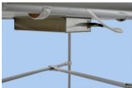
Рисунок 2 – Блок конденсаторов
