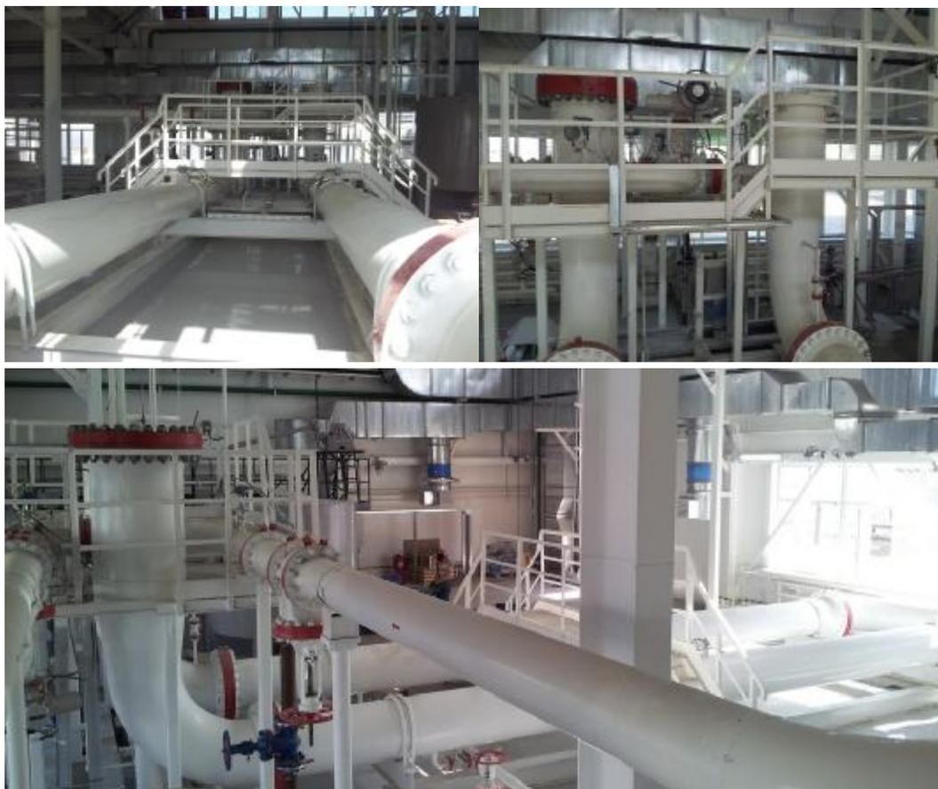
При работе ТПУ и поверяемое или контролируемое средство измерений соединяют последовательно. Через технологическую схему с ТПУ и средство измерений устанавливают необходимое значение расхода жидкости. Поток жидкости, проходящей через ТПУ, увлекает шаровый поршень, который перемещается по калиброванному участку. При воздействии шарового поршня на толкатели детекторов происходит срабатывание их микровыключателей, которые
