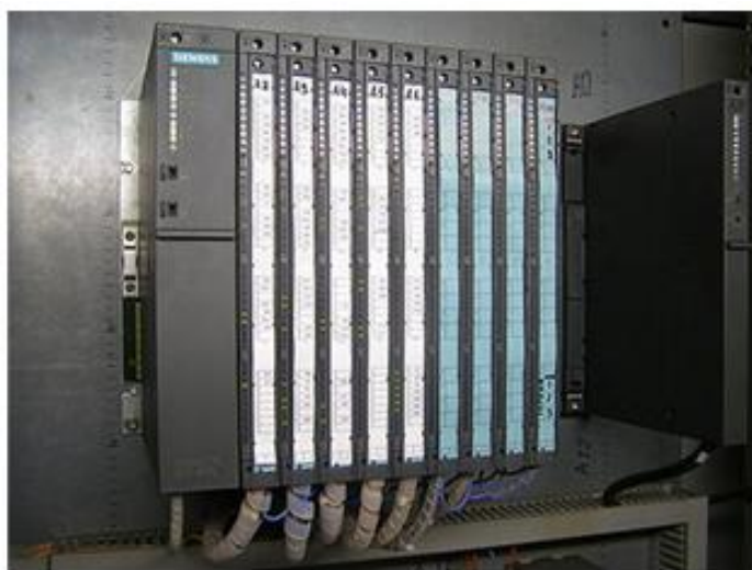
Рисунок 2 - Программируемый контроллер Simatic S7-400
