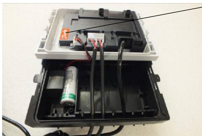
Пломба на вычислителе теплосчетчика Sonometer 1100
