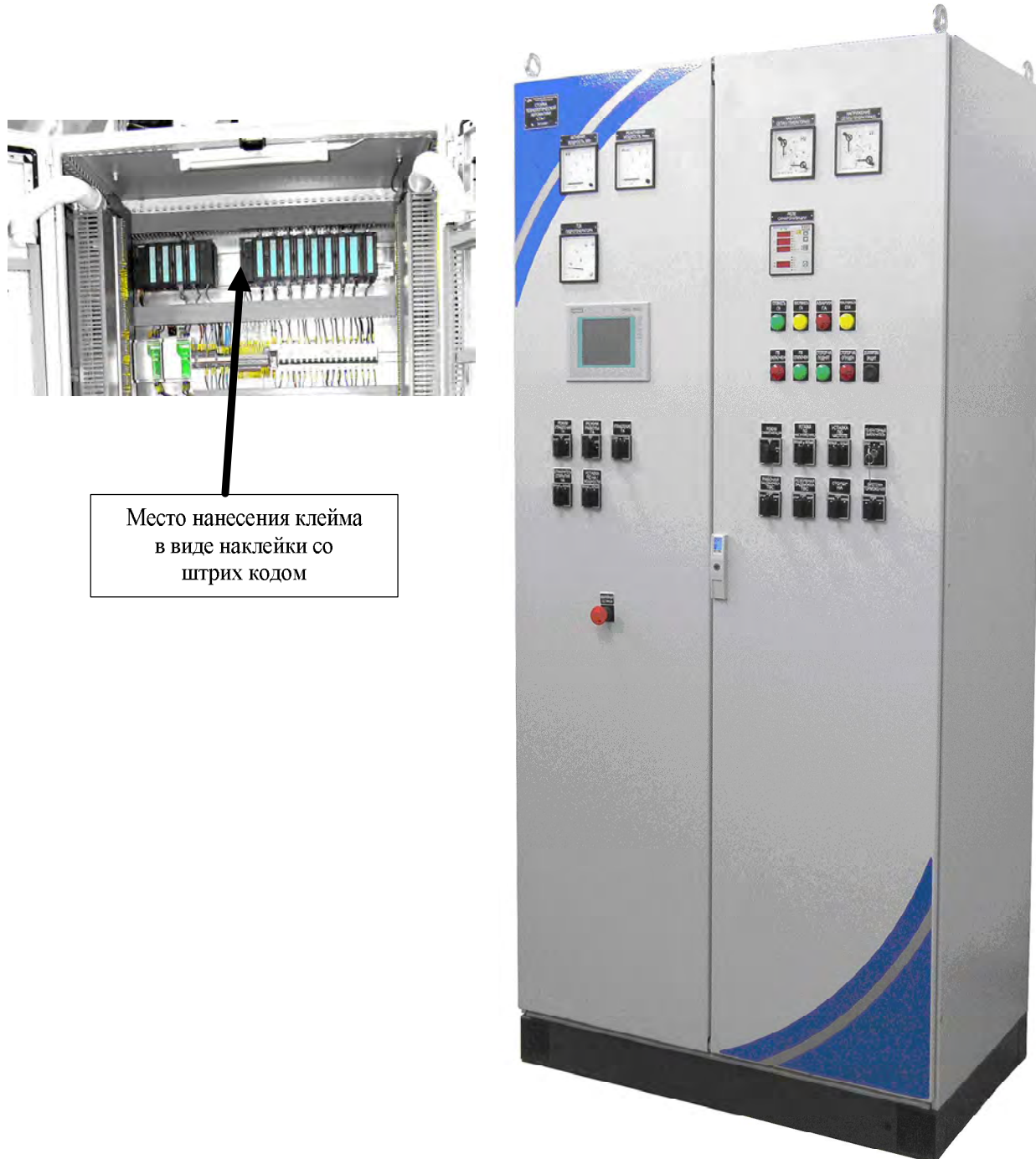
Рисунок 1 - Внешний вид стойки регулятора СТА-1 и схема нанесения клейма.
