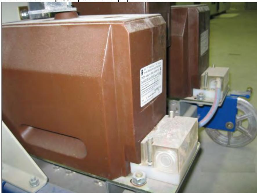
Выводы вторичной обмотки и заземляемый вывод первичной обмотки трансформаторов выполнены в виде болтов М6 и расположены в контактной коробке, закрываемой изоляционной пломбируемой крышкой в передней торцевой части трансформатора вниз.
