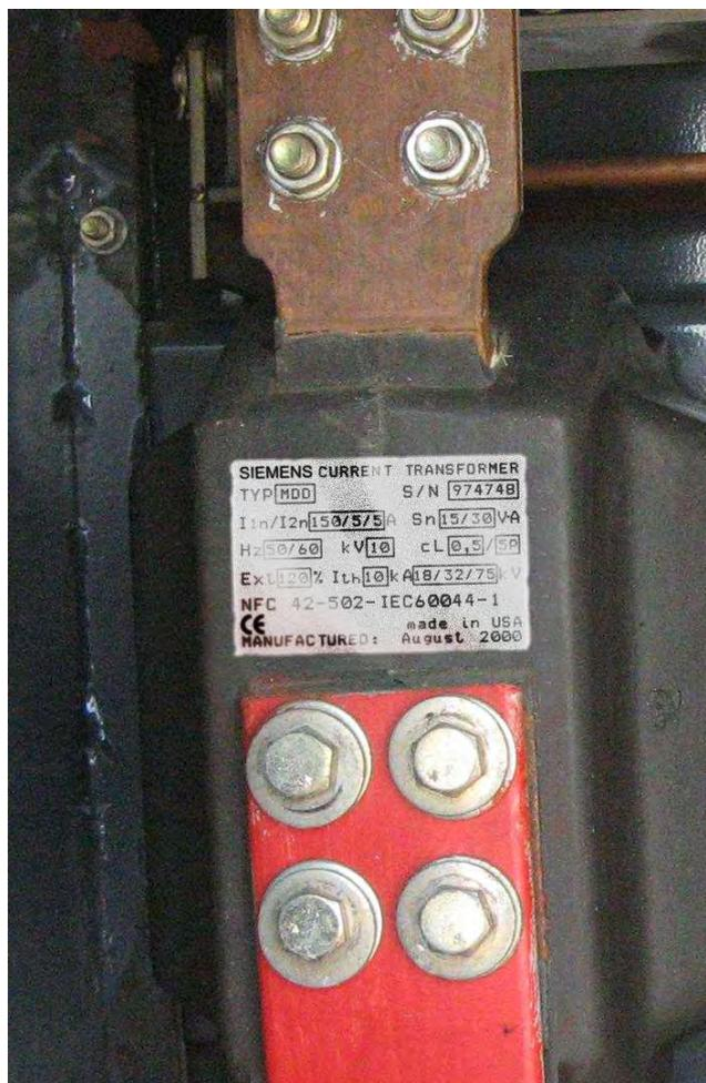
Первичные и вторичные обмотки залиты эпоксидным компаундом, который обеспечивает основную изоляцию и формирует корпус трансформатора. Выводы первичной обмотки выведены на верхнюю часть корпуса в виде контактных площадок. Вторичные обмотки выведены в коробку для зажимов, закрытую крышкой. Крышка, закрывающая зажимы, пломбируется для исключения несанкционированного доступа.
