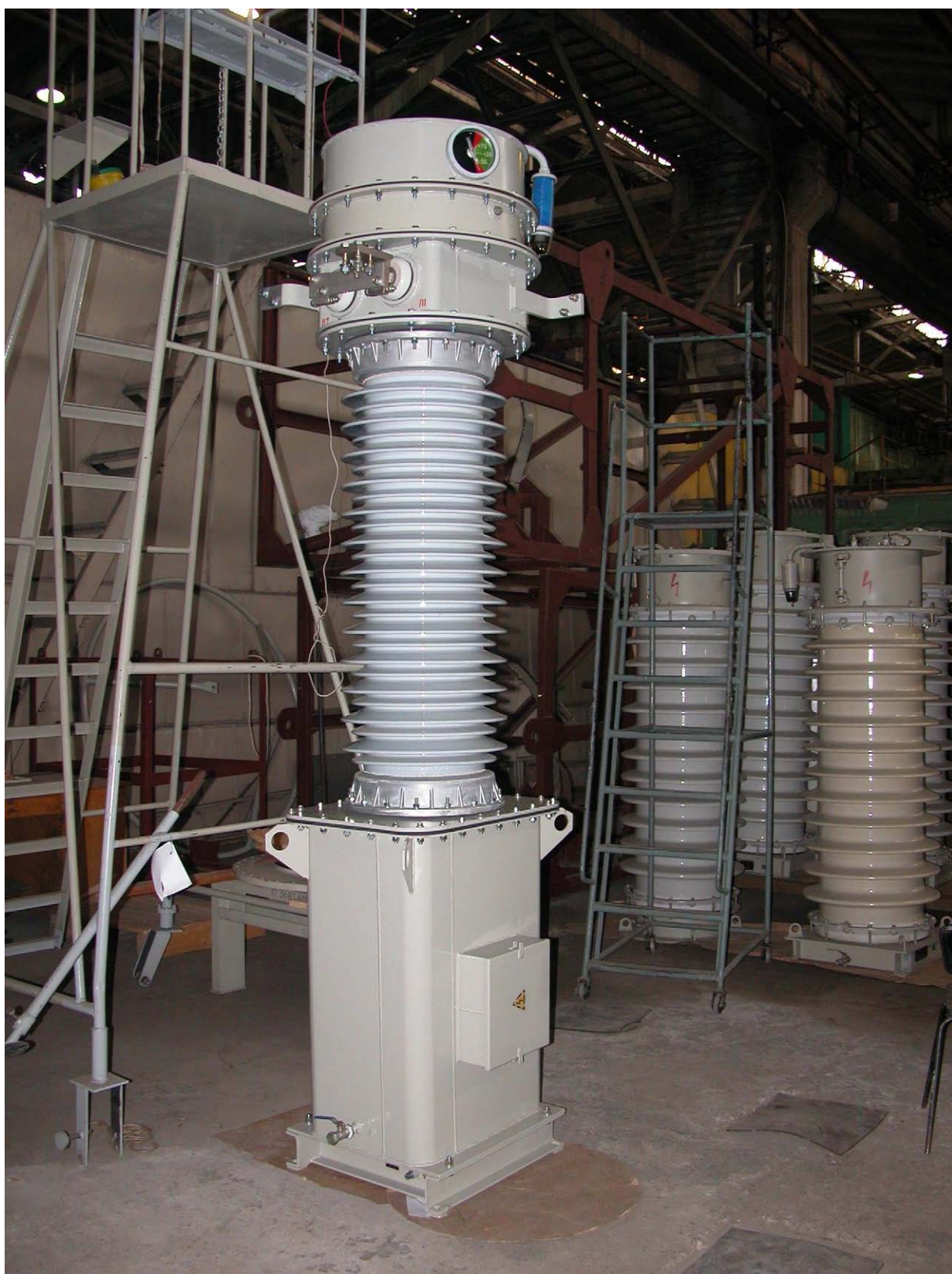
Рис.1 Трансформатор тока ТФБ 110
