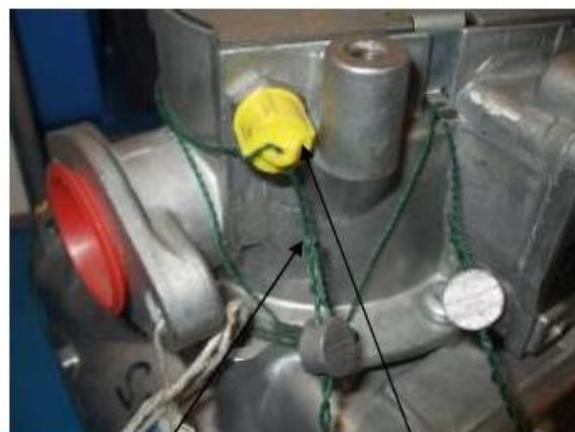
Рис. 2 Пломбирование гидравлического модуля и объемомера
