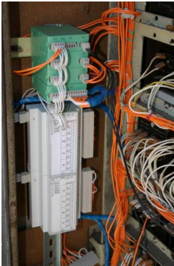
Рисунок 1 – Внешний вид контроллера КДСТ
