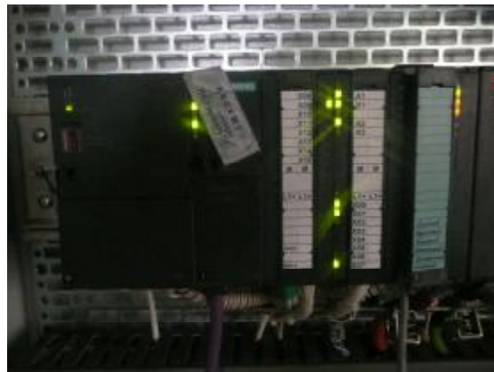
Рисунок 2- Бумажная пломба наклеенная на разъем флеш-карты
