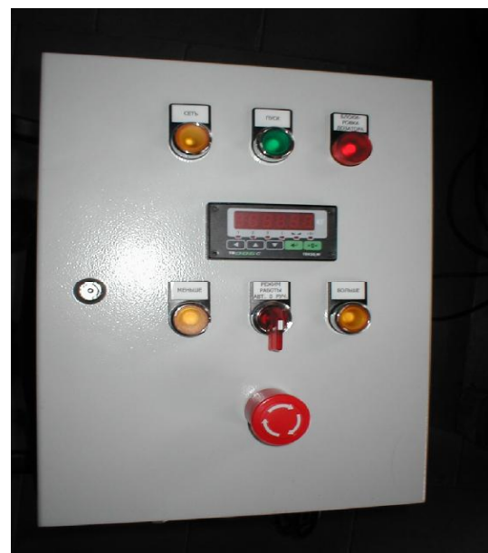
Рисунок 3 - Внешний вид многофункционального шкафа управления МША
