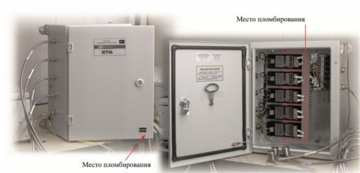
Рисунок 1 – Шкафы с измерительными преобразователями
