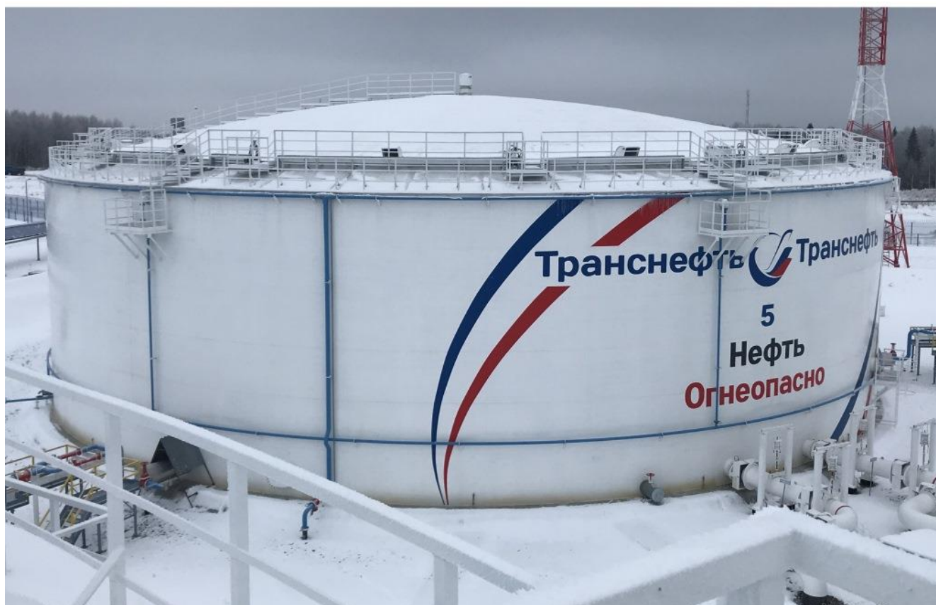
Рисунок 1 – Общий вид резервуаров РВСП-20000
