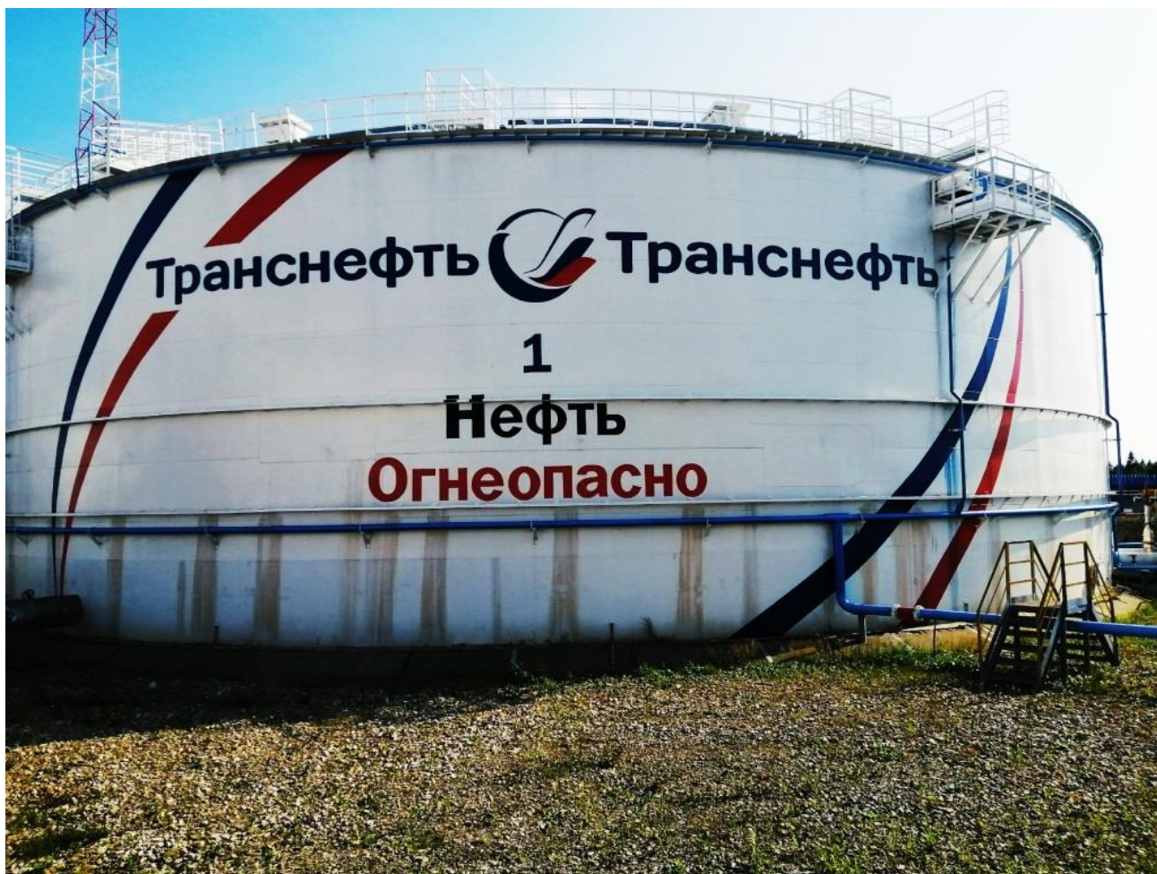
Рисунок 1 – Общий вид резервуара РВС-20000
