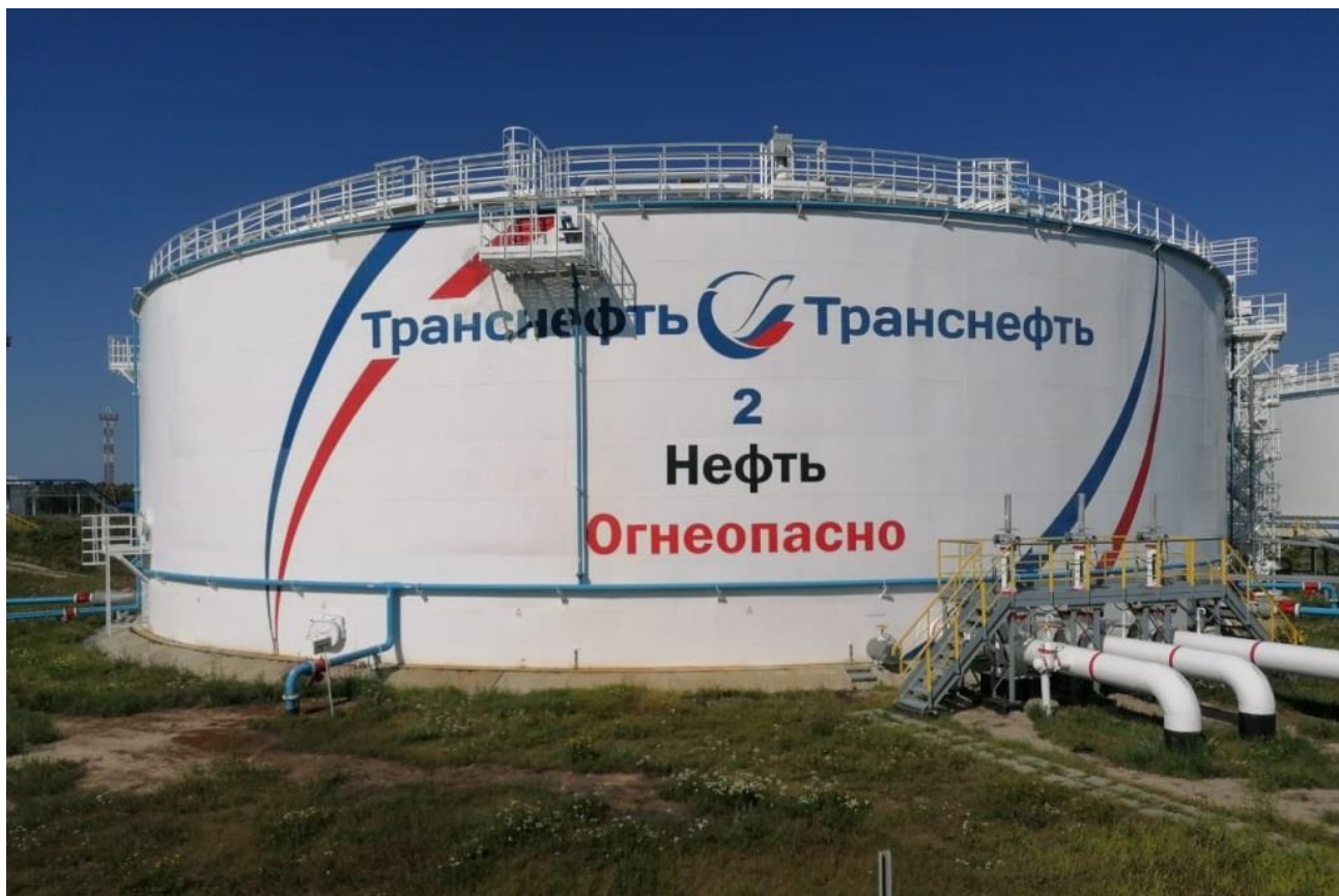
Рисунок 1 – Общий вид резервуара РВСП-20000
