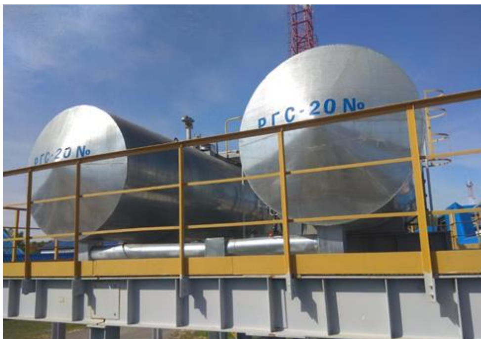
Рисунок 1 – Общий вид резервуаров РГС-20 (17+3) зав.№ 247, зав.№ 248
