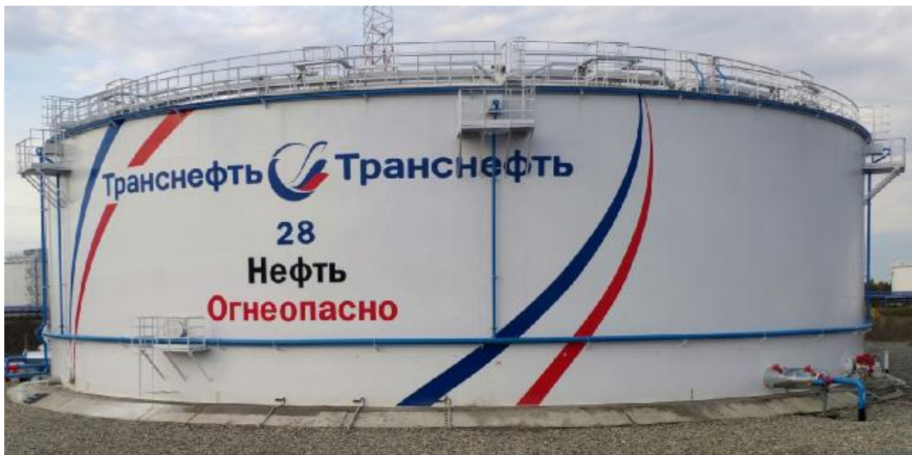
Рисунок 1 – Общий вид резервуара РВСП-20000 зав.№ 28
