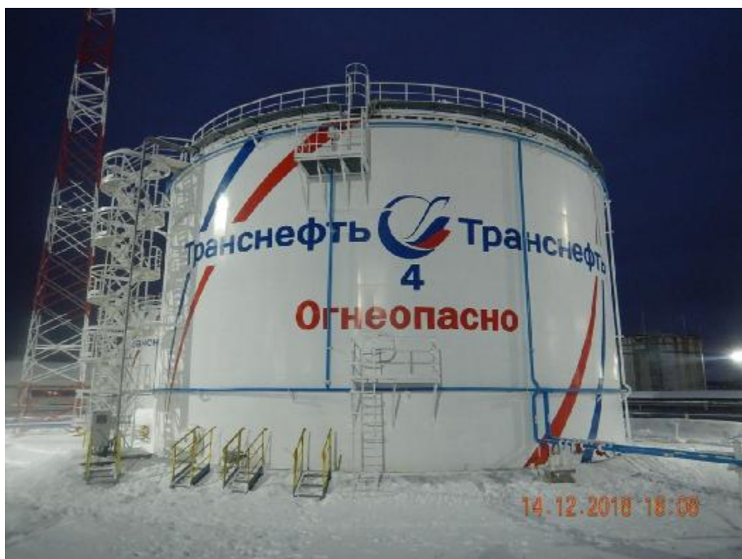
Рисунок 1 – Общий вид резервуара РВСП-5000 зав.№ 4
