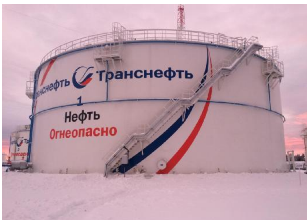
Рисунок 2 – Общий вид резервуара РВС-10000 зав.№ 1
