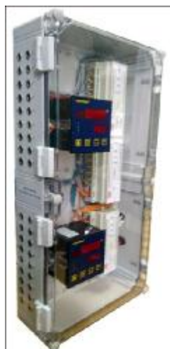
Рисунок 4 – Шкаф измерительный температуры
