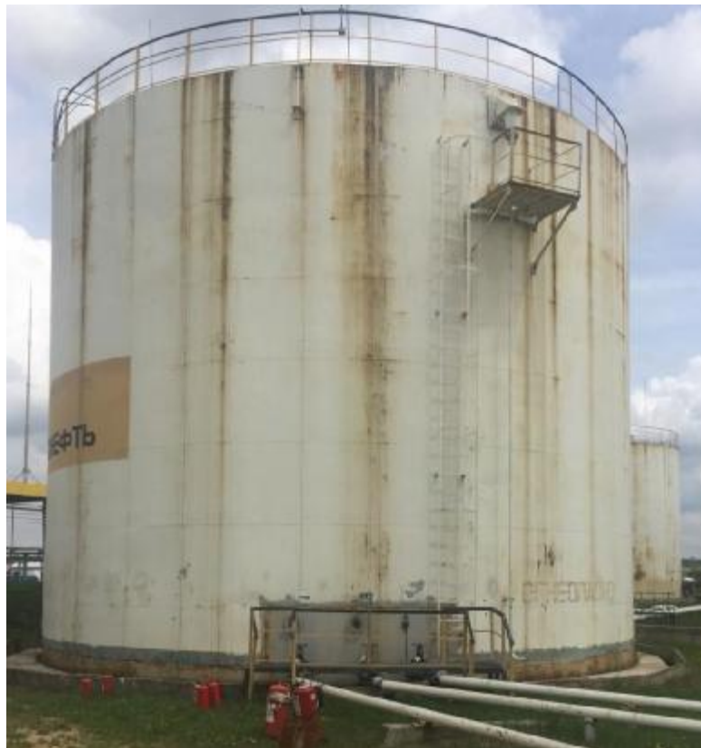
Рисунок 1 – Общий вид резервуара стального вертикального цилиндрического РВС-2000
