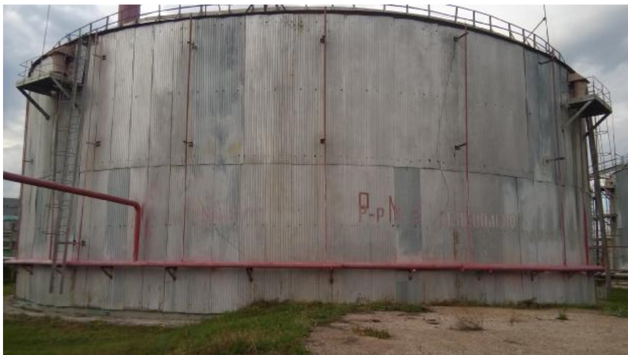
Рисунок 1 – Общий вид резервуаров стальных вертикальных цилиндрических РВС-10000 № 31, № 32
