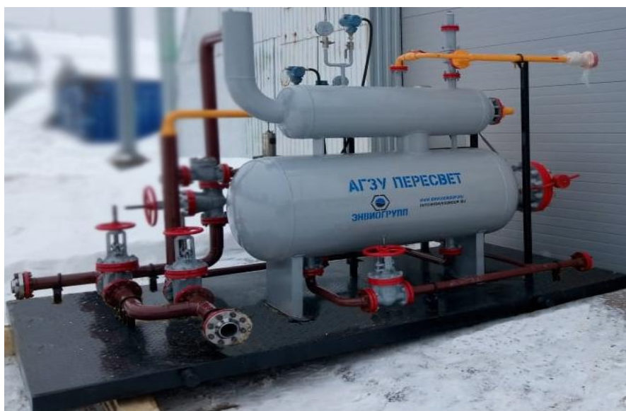
Рисунок 1 – Внешний вид установки измерительной групповой автоматизированной «АГЗУ-ПЕРЕСВЕТ»
