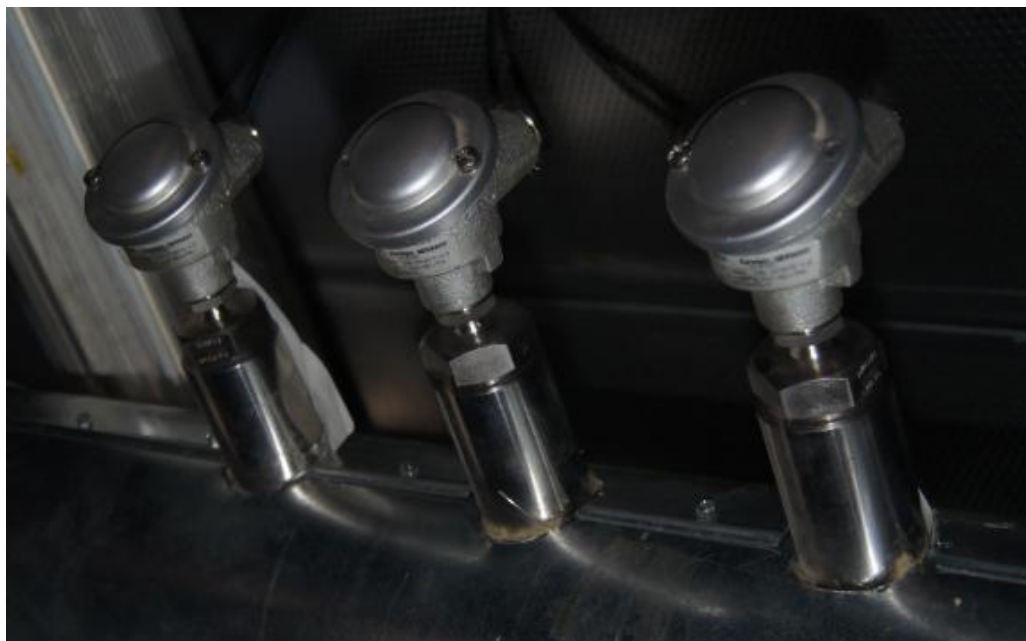
Рис. 1. Внешний вид термопреобразователя сопротивления платинового модели 2Pt100/В/2 исполнения 31151621.
